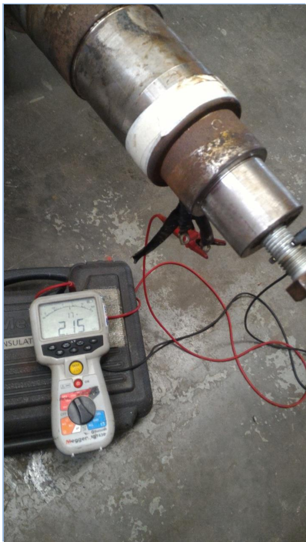
PI test untuk rotor Generator
